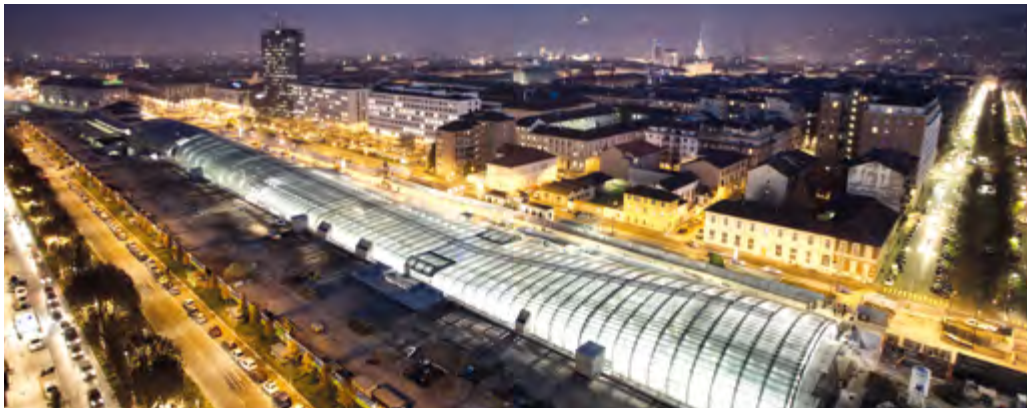
Centrale termica. / Oval. Stazione Ferroviaria di Porta Susa.
